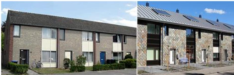
**Figura 2.9: Casas en Roosendaal. Antes (izquierda) y después (derecha) del mejoramiento. Demanda energética para calefacción antes del mejoramiento: 150 kWh/m<sup>2</sup> año, y después de él: 25 kWh/m<sup>2</sup> año. (<http://www.e2rebuild.eu>, 2012).**
