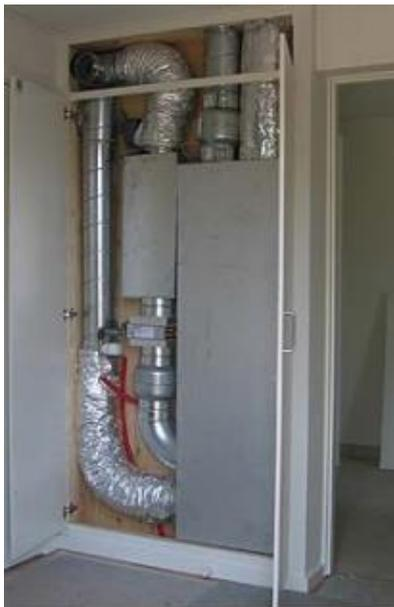
**Figura 3.4:** Sistema de Ventilación con recuperación de calor dentro de un closet (Intelliget Energy Europe, 2008).
