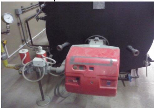
Figura 2.23 Quemador de combustible
