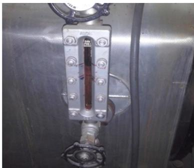
Figura 2.21 Medidor de nivel visual
