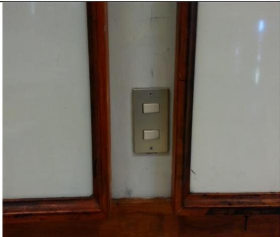
Foto 5. Aula – Interruptores. Puede apreciarse la existencia de estos elementos en la sala. No obstante, la ubicación de estos y la altura a la que se encuentran, no permiten accesibilidad.
