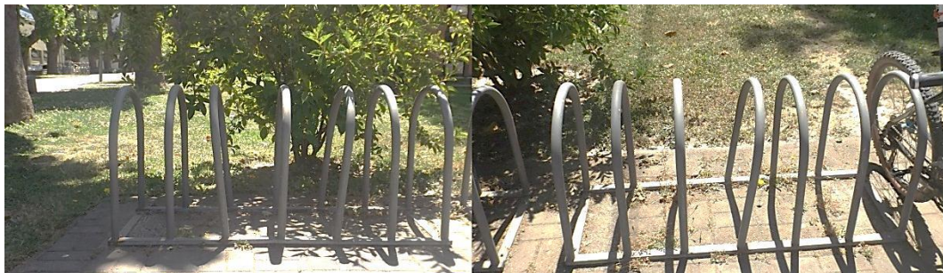
Figura 16: Biciestacionamientos en mal estado
