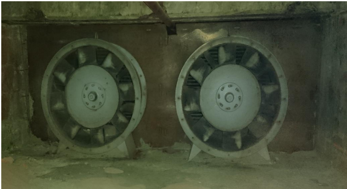
Figura 4.9 Ventiladores encargados de impulsar el aire.
