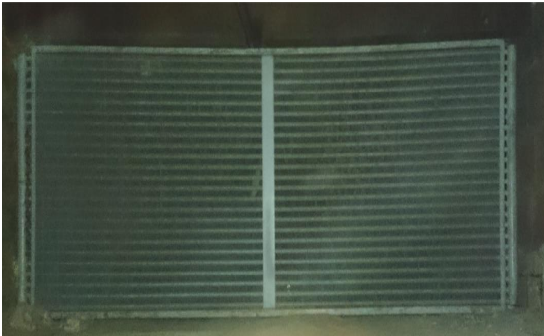
Figura 4.8 Radiador o convector por donde circula el aire.
