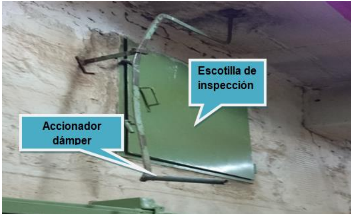
Figura 4.11 Accionador d&acirc;mpar y escotilla de inspecci&acirc;n.
